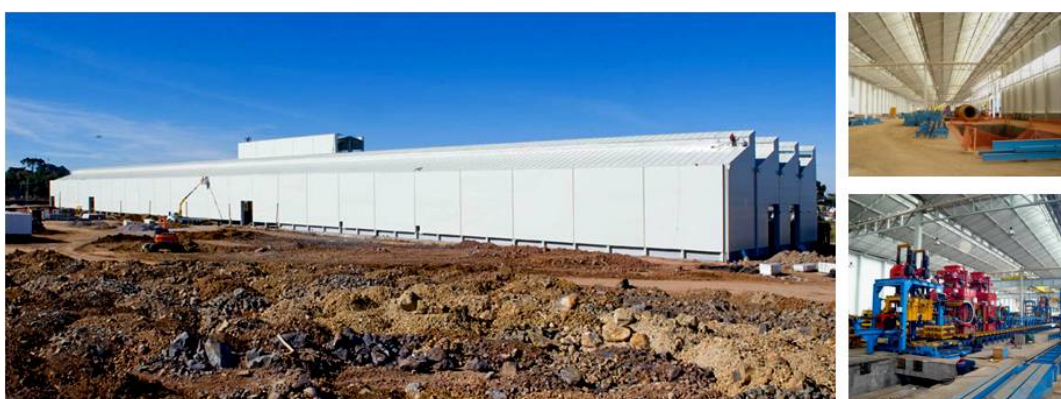
Obras da Castertech
