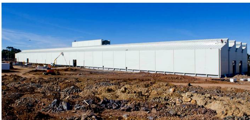
Obras da Castertech
